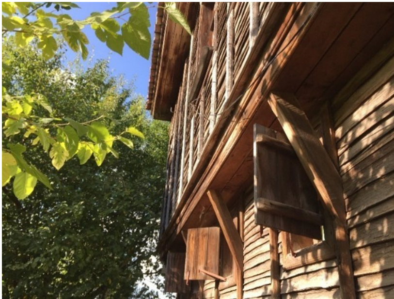
Ил. 1. Фасадна обшивка, изпълнена с цепени дъски (гр. Царево, кв. Василико). Архив Сдружение „Мещра“, сн. М. Кафкова, 2016 г.
